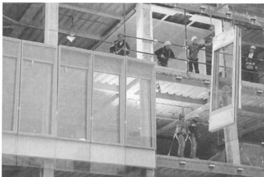
In apertura: le due torri sorgono sopra la stazione ferroviaria Porta Garibaldi, ridefinendo l'immagine dell'intera zona. A sinistra: montaggio delle cellule prefabbricate d'involucro sui supporti saldati alla struttura portante esistente, opportunamente rinforzata.
