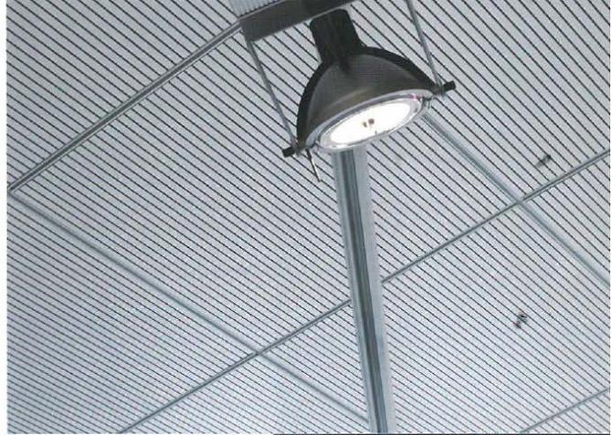
**Climacoustic di Fantoni** unisce comfort termico, risparmio energetico e qualità del suono. È un sistema modulare costituito da pannelli 60x60 cm o 60x120 cm. I moduli sono composti da un pannello in MDF con finitura superficiale melamminica, una serpentina interna realizzata con tubo PeRT, un foglio in alluminio e uno strato isolante in EPS di spessore 35 mm, accoppiato al pannello in MDF
