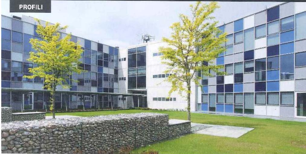
Il vetro utilizzato per le facciate è High Performance, con un sistema di isolamento ed elementi retro-smaltati che creano un effetto multicolore. (foto ©Cesar Ferrari)
