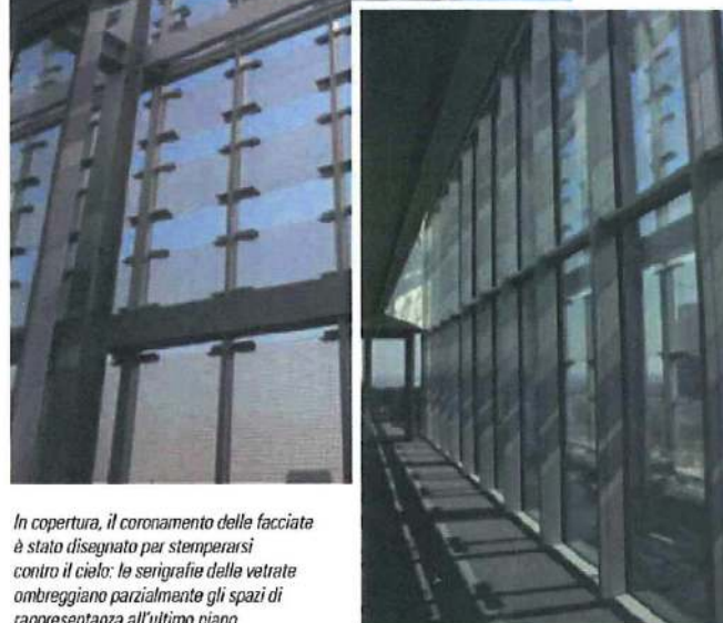
Le serre bioclimatiche a doppia altezza sono poste lungo lo spigolo meridionale del prospetto sud-ovest: riducono il carico termico estivo e contribuiscono al fabbisogno termico in regime invernale
