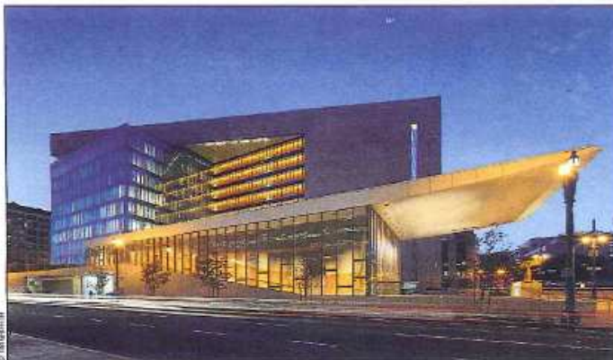
Aecom sul tetto del mondo. La nuova sede del Los Angeles Police Department (Lapd), progettata dalla società americana Aecom con Roth Sheppard Associates nel 2009 vincitrice del Grand Prize all'edizione 2010 dei Los Angeles Architectural Awards. Lo studio statunitense si è appena aggiudicato una consulenza da 150 milioni di dollari per il megaponte tra Hong Kong e Macao, in costruzione entro il 2016
