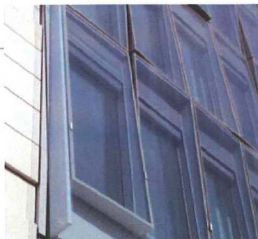
Le cellule che compongono la facciata interattiva sono progettate e realizzate su misura da Permasteelisa, utilizzando elementi in alluminio realizzati da un produttore italiano specializzato
