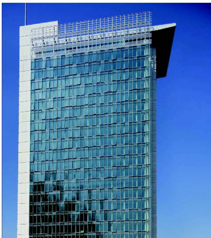
La facciata sud-ovest, con la superficie fotovoltaica al centro. Ai lati si notano le serre con le relative schermature orizzontali
