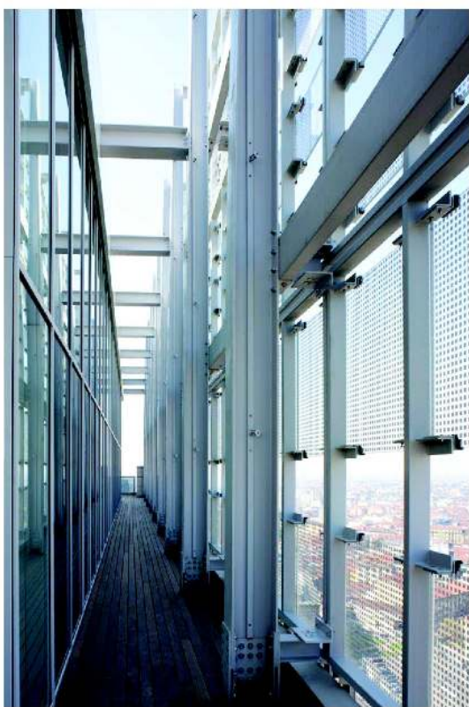
Il nuovo coronamento della torre. A sinistra, il corpo vetrato del 25° piano; a destra, i pannelli serigrafati che fanno "sfumare" l'edificio nel cielo
