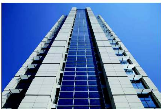
La facciata sud-ovest, con la superficie fotovoltaica al centro. Ai lati si notano le serre con le relative schermature orizzontali
