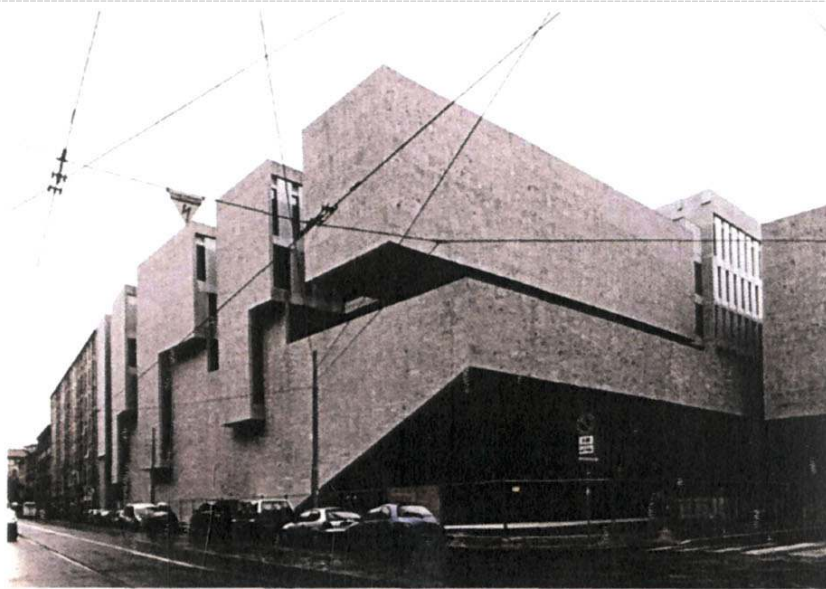
L'edificio visto da viale Bligny, angolo via Röntgen.
