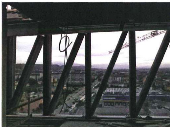
Immagini 3a, b. Modellazione toroidale dell'involucro. La costruzione concava, nell'escludere il richiamo a una tipologia consolidata, si manifesta secondo una condizione, "erachitea" (3a), accentuata dalla percezione, aperta o rastremata, condotta dall'avvolgimento reticolare sul perimetro anulare. La composizione portante, di supporto alle chiusure verticali vetrate (3b), si sviluppa rispetto all'esecuzione di interfacce differenti, comportando un andamento deformato nelle tre dimensioni e generando effetti visivi variabili in base alla posizione
