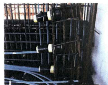
Ancoraggio dei cavi per la post tensione.
