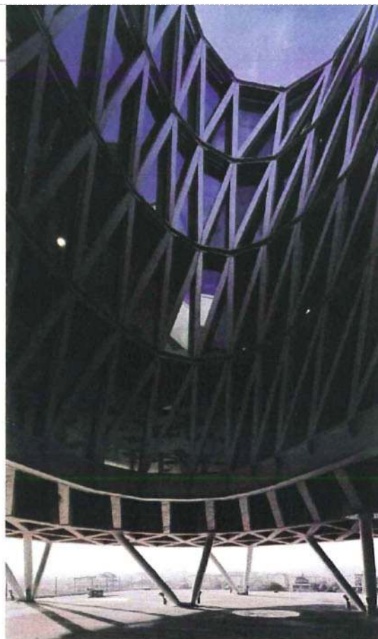
Immagini 3a, b. Modellazione toroidale dell'involucro. La costruzione concava, nell'escludere il richiamo a una tipologia consolidata, si manifesta secondo una condizione, "erachitea" (3a), accentuata dalla percezione, aperta o rastremata, condotta dall'avvolgimento reticolare sul perimetro anulare. La composizione portante, di supporto alle chiusure verticali vetrate (3b), si sviluppa rispetto all'esecuzione di interfacce differenti, comportando un andamento deformato nelle tre dimensioni e generando effetti visivi variabili in base alla posizione
