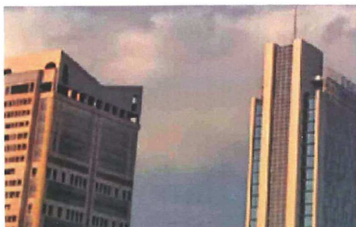
La nuova facciata interattiva della Torre B (a destra) a confronto con quella della Torre A, attualmente anch'essa in corso di recladding con un intervento simile a quello già realizzato
