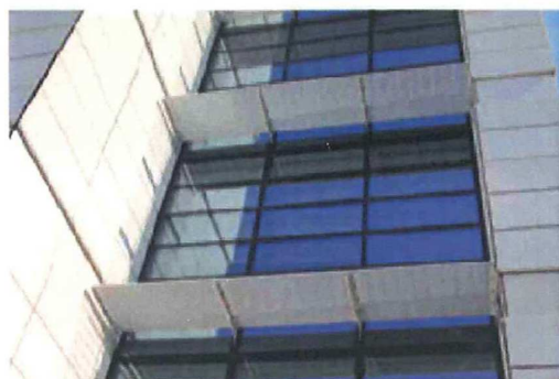
Le serre bioclimatiche a doppia altezza sono poste lungo lo spigolo meridionale del prospetto sud-ovest: riducono il carico termico estivo e contribuiscono al fabbisogno termico in regime invernale
