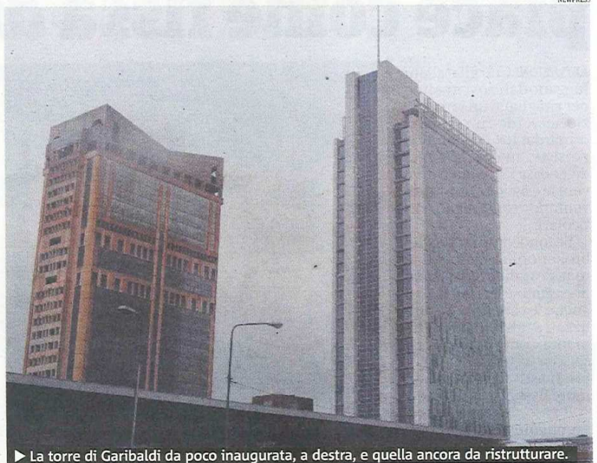
► La torre di Garibaldi da poco inaugurata, a destra, e quella ancora da ristrutturare.
