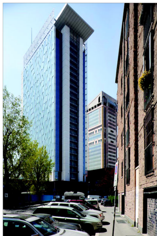
La torre vista dal quartiere Isola: in evidenza il deck asimmetrico in copertura, che ospita i pannelli solari e la vasca per la raccolta dell'acqua
